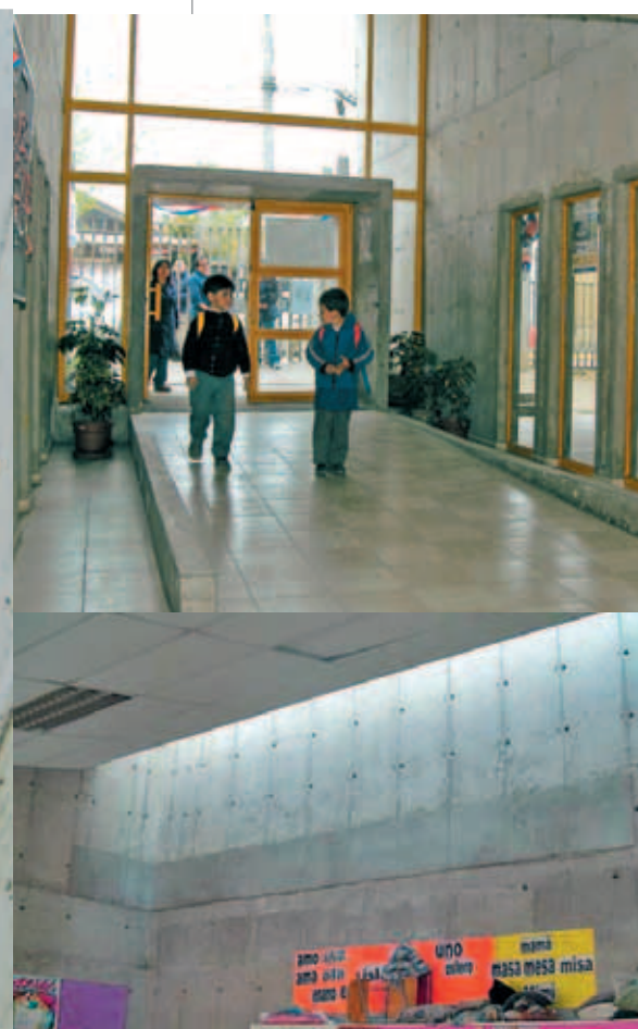
Rampa de acceso.
