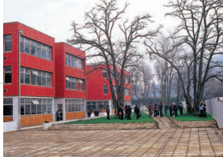
Patio exterior integrado al espacio urbano.
