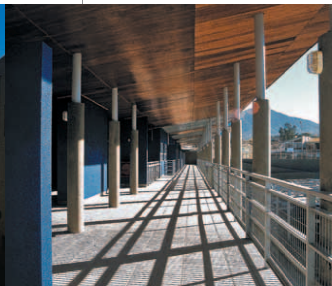
El cielo de los pasillos se inclina para abrir las vistas.
