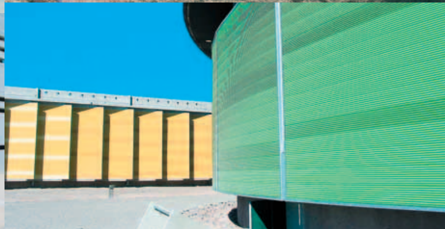
Los revestimientos metálicos permiten manejar la radiación solar.
