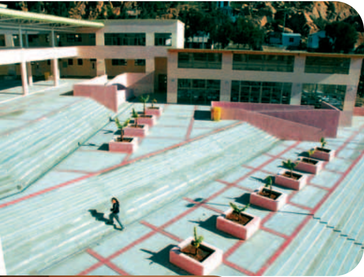
Vista de las terrazas escalonadas.
