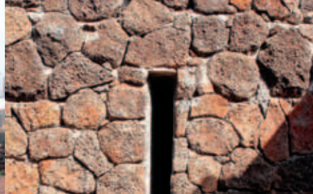
Detalle de la mampostería de piedra.
