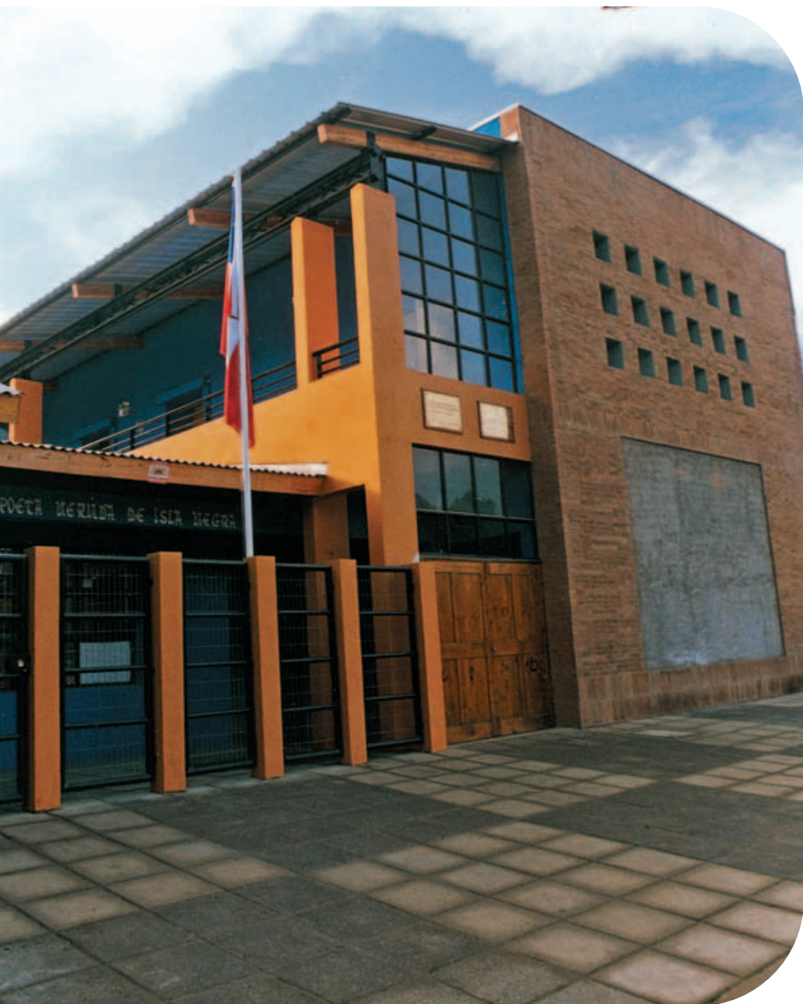
Fachada y acceso.
