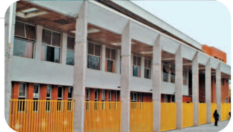
Una reja liviana y pilares de hormigón separan el colegio del nuevo paseo peatonal.
