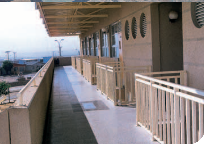
Las aberturas en el piso permiten la circulación vertical del aire.
