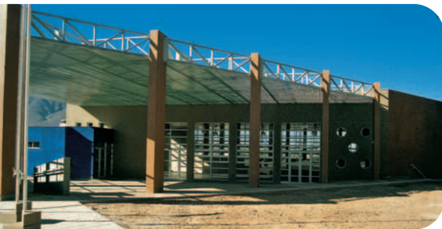
El acceso al comedor es a través del patio cubierto.
