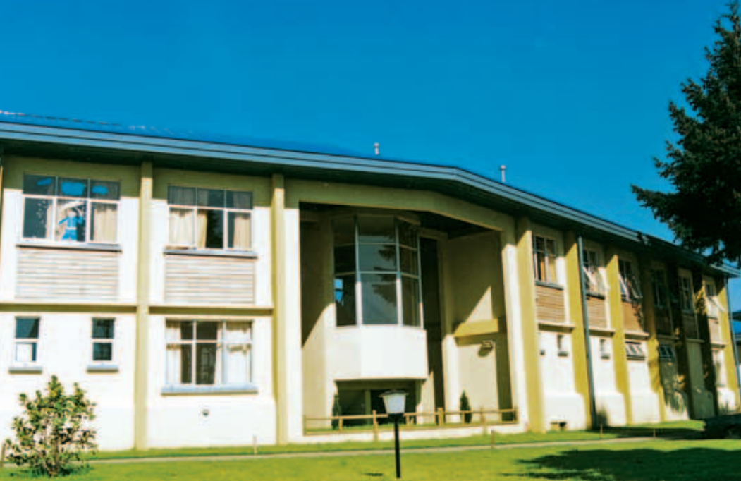
Detalle de la fachada nororiente.
