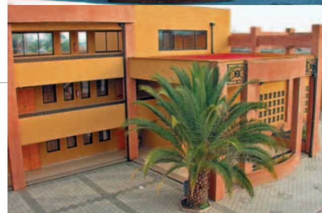
Vista de pasillos y sala de espectáculos, lado sur.
