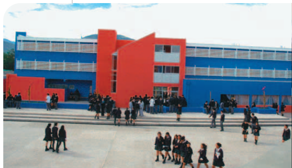
El internado visto desde la plaza interior del establecimiento.
