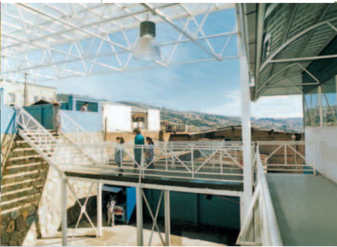
Puente entre niveles de patio.
