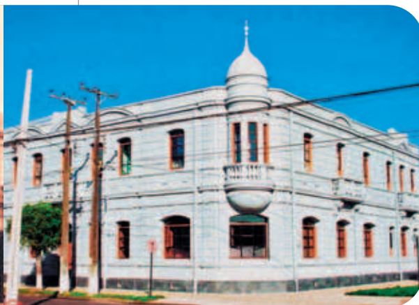
Estado actual, luego del mejoramiento.
