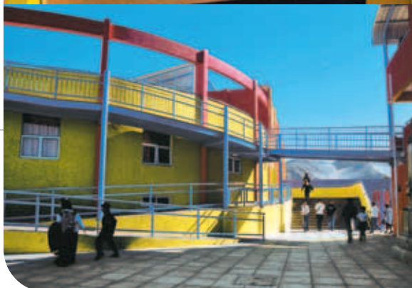
El volumen curvo contiene la rampa para discapacitados.
