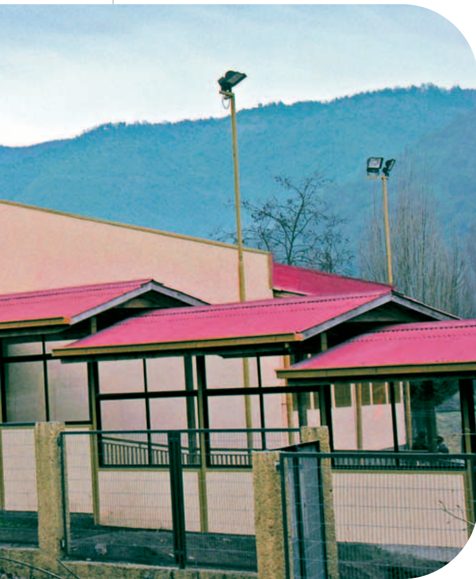
Vista general del colegio.
