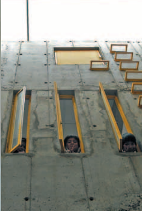
El tragaluz permite iluminar el acceso a las aulas del segundo piso.
