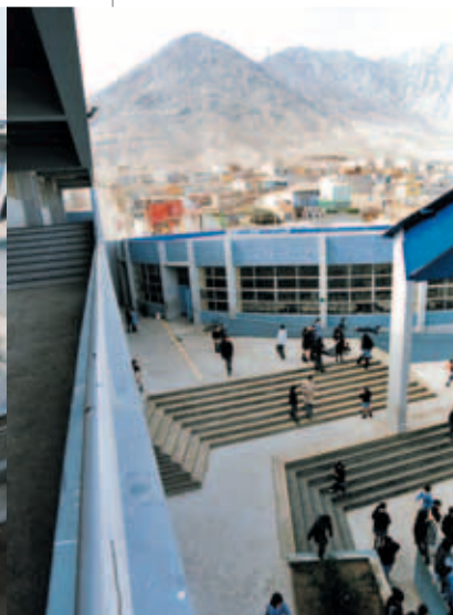
Escaleras dan cuenta del desnivel del terreno.
