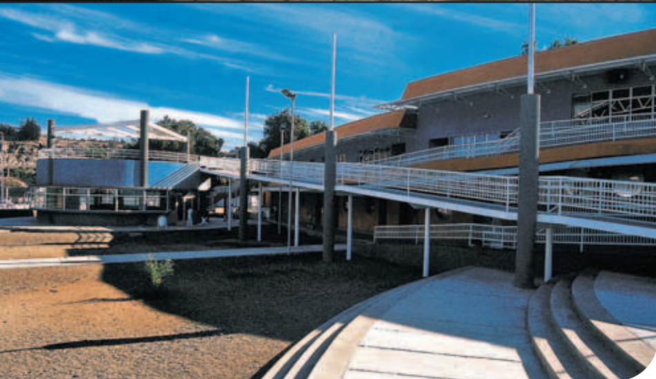
Rampa y pasillos interiores.
