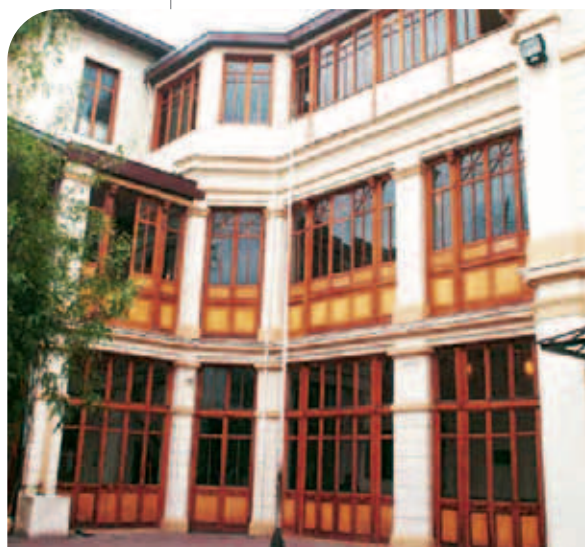
Fachada interior restaurada.
