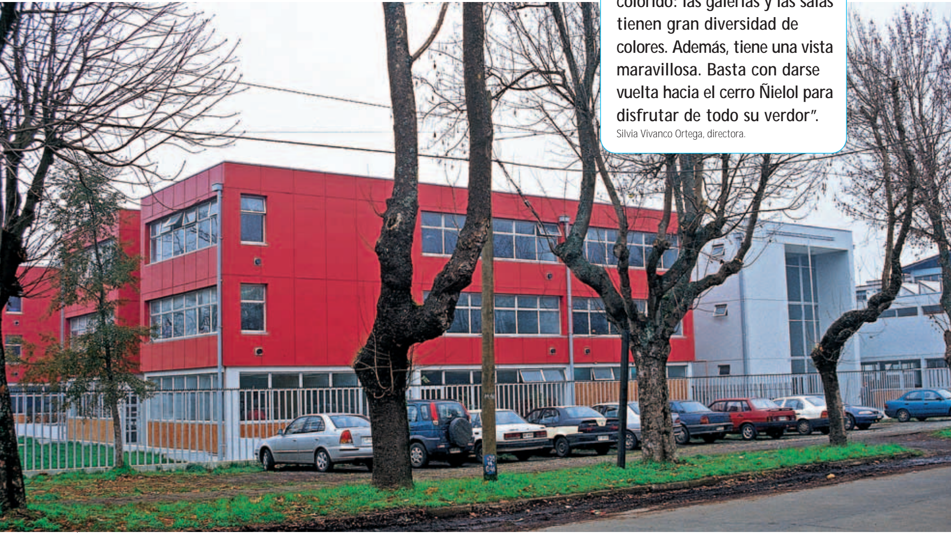
Fachada del acceso principal, con estacionamiento.
