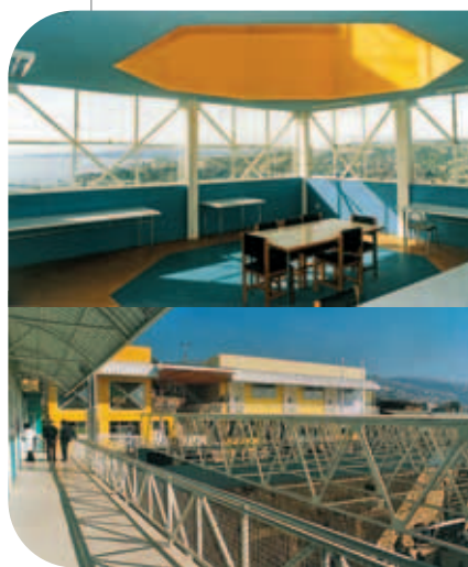
Estructura de la cubierta del patio.
