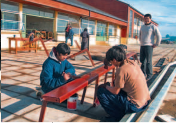
Alumnos trabajando en estructuras metálicas.
