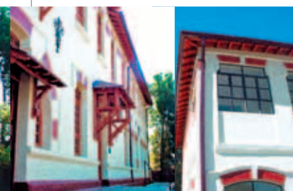
Detalle de la cornisa.
