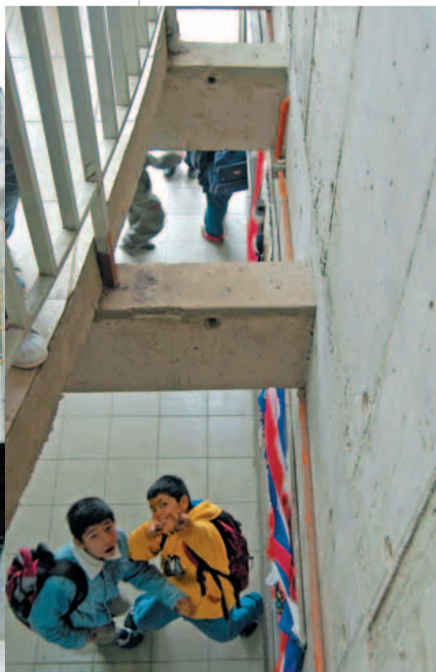
Abertura que permite una conexión vertical entre pisos.
