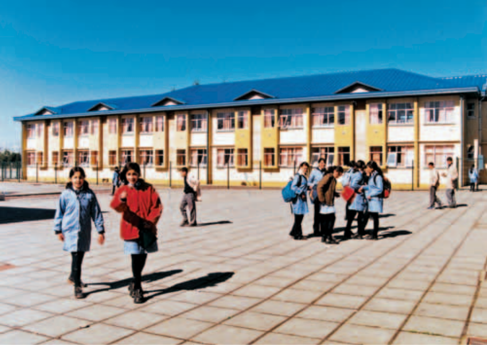
Patio y edificio del internado.
