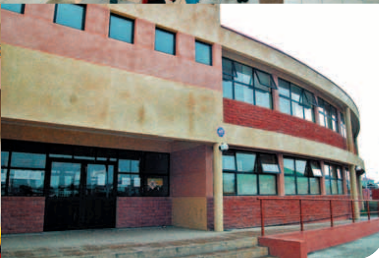
Vista exterior del acceso principal.
