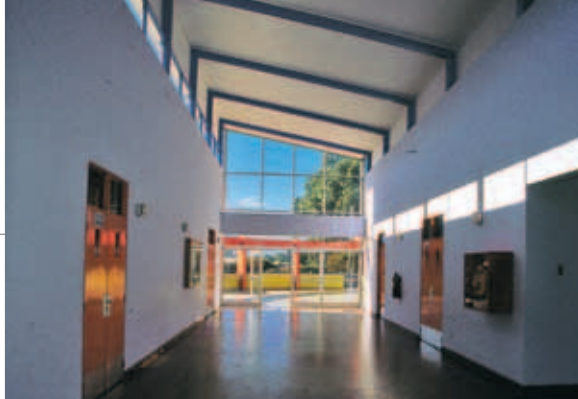
Pasillo interior del segundo piso.
