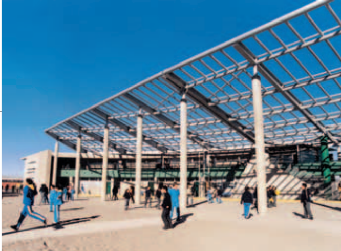
Patio del pabellón principal, con sombreadero inclinado.
