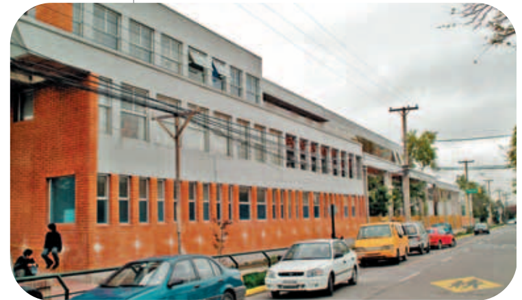
En el segundo piso, ventanas de las terrazas y columnas dan continuidad a la edificación.
