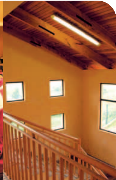
Las escaleras son amplias y luminosas.
