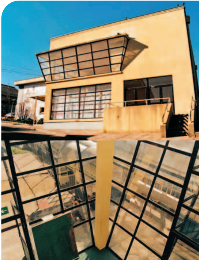
Vista exterior del comedor.
