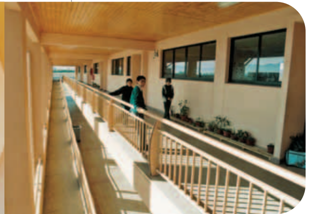
La accesibilidad al segundo piso está resuelta por una rampa.
