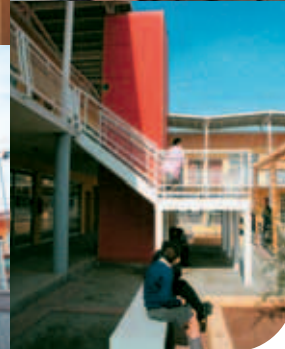
Escalera y ascensor.
