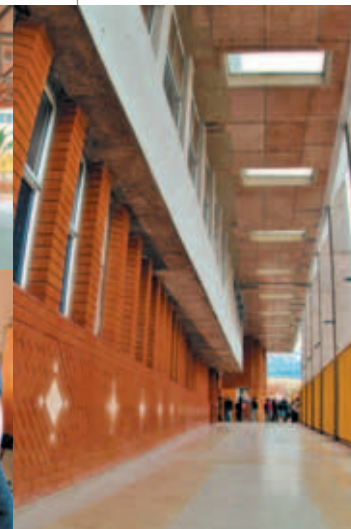
Enchape de ladrillo.
