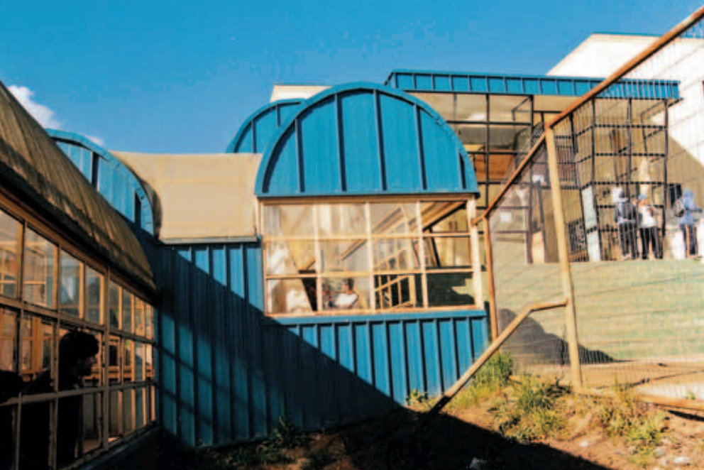
Vista exterior del pasillo cubierto.
