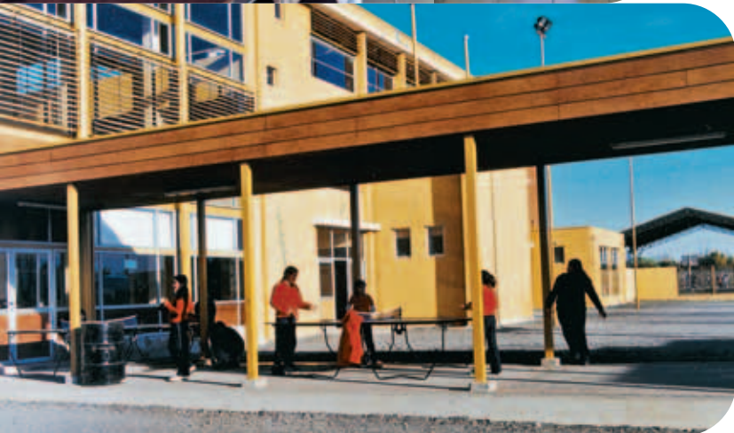
Pasillo exterior cubierto.
