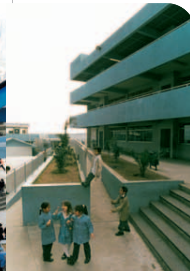
Vista hacia el acceso, con la rampa para discapacitados en primer plano.
