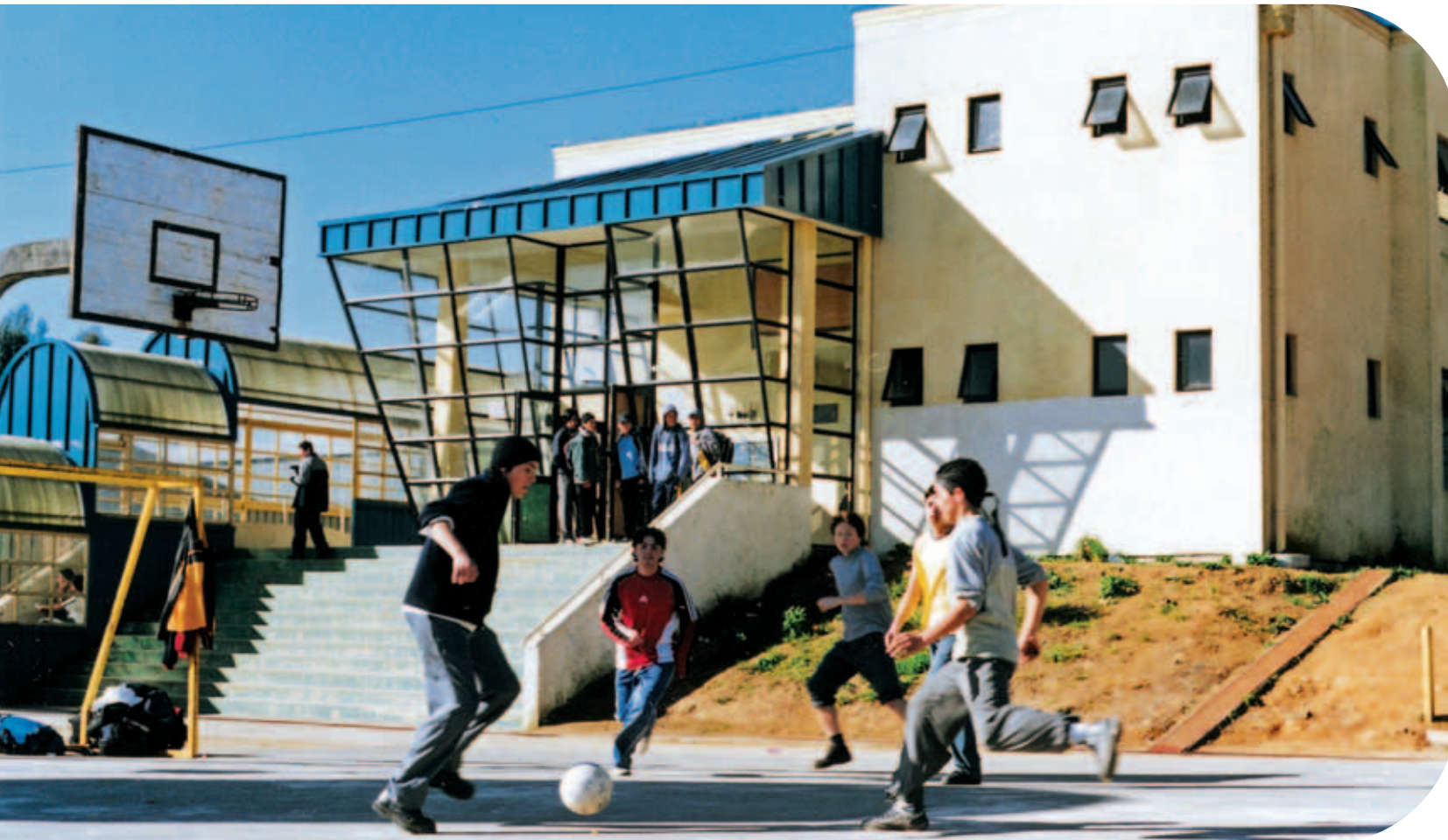
Multicancha y edificio de sala de clases.
