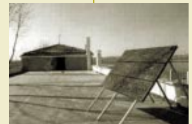
Colectores solares. Placas móviles.
