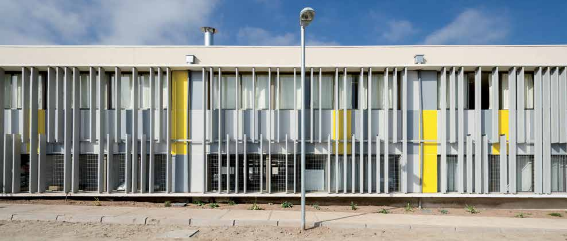
Vista de la textura de la fachada que regula la luminosidad interior de las aulas.
