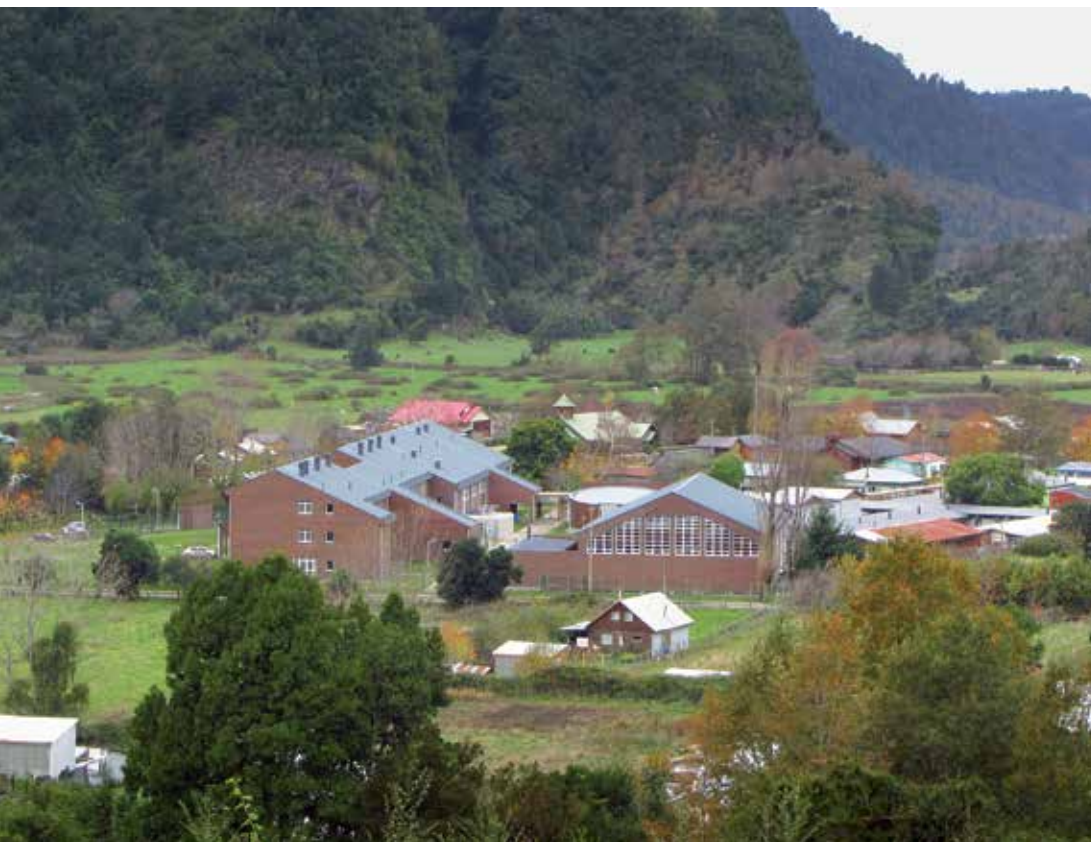
Vista general del complejo, en la cual se puede entender cómo se inserta y se vincula con el entorno.
