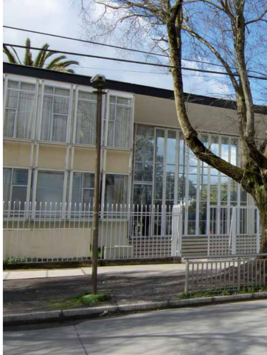
Vista del acceso principal.
