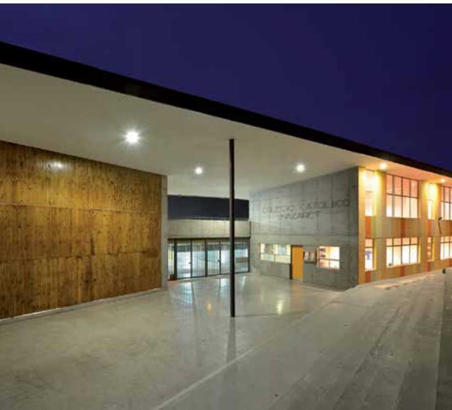
Vista nocturna del acceso principal.
