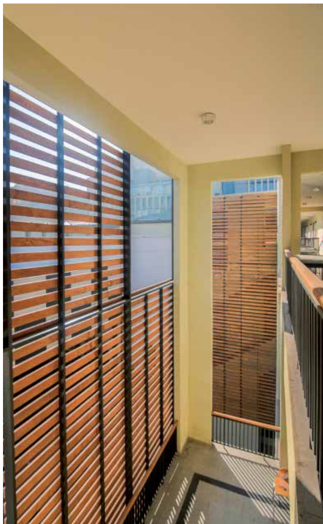
Las nuevas celosías controlan el traspaso de la luz natural en la fachada norte.
