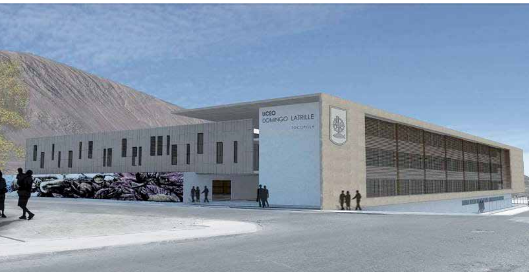
Vista de la fachada principal.
