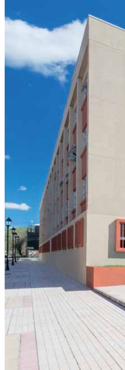
Vista del gran acceso principal acristalado
