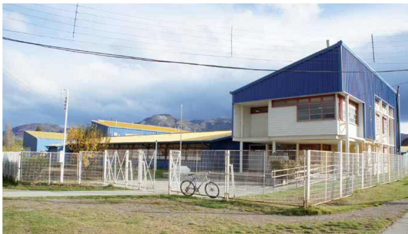
Vista de la antigua fachada y el acceso previo a la remodelación
