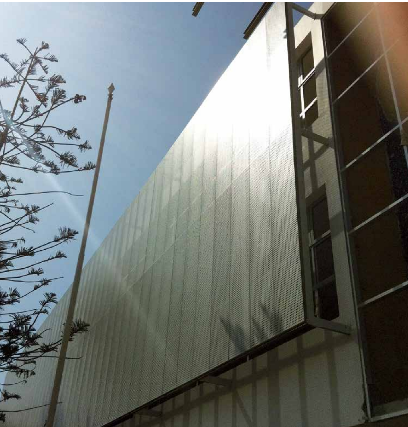
Vista de detalle de fachada remodelada.
