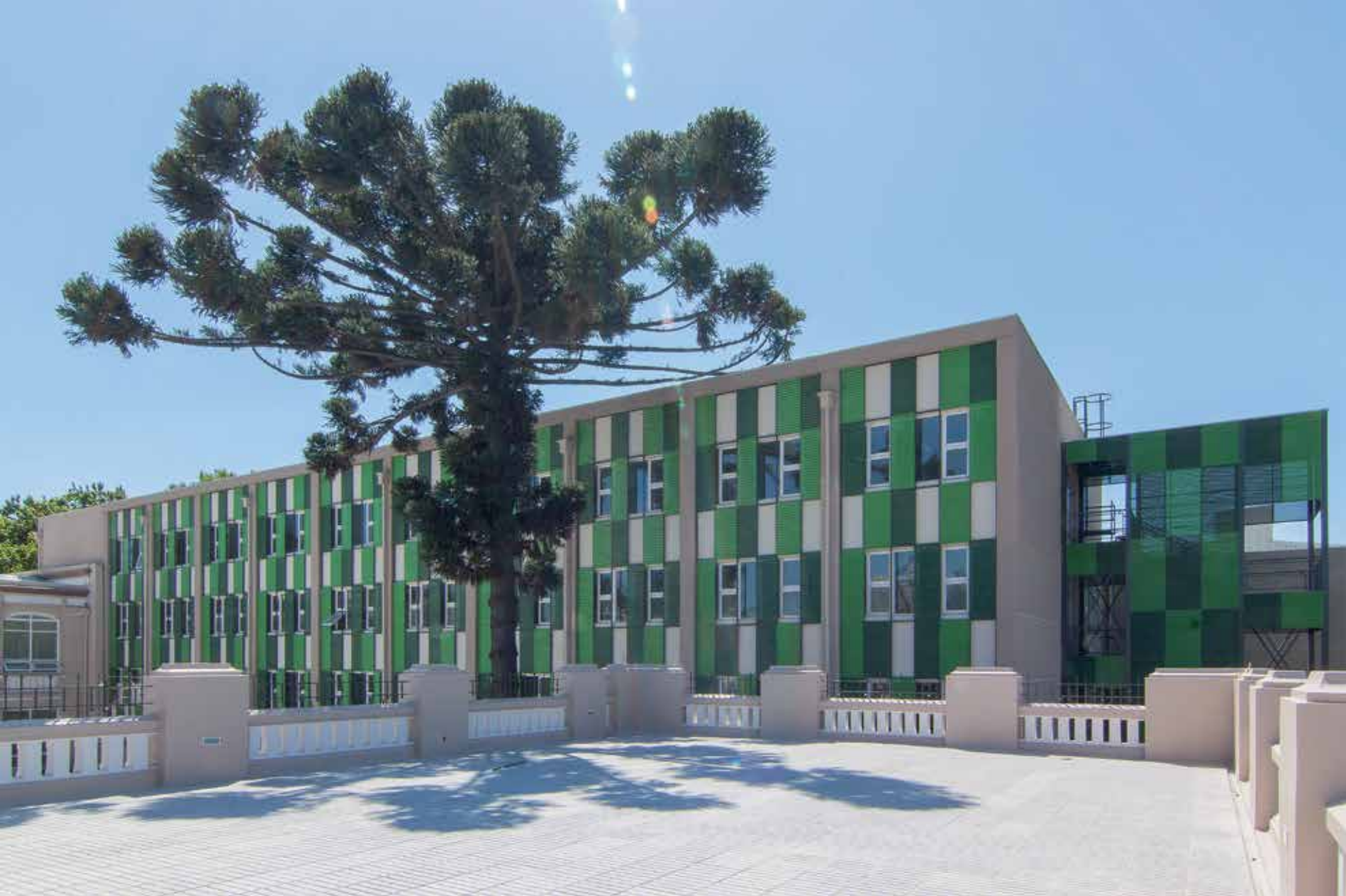
Vista de la fachada que combina formas, colores y relieves.
