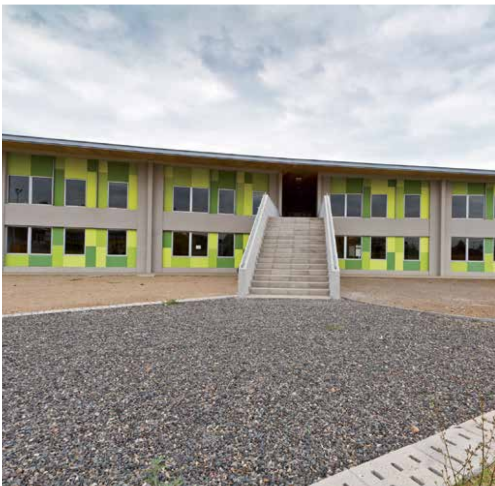
Escalera central al segundo piso
