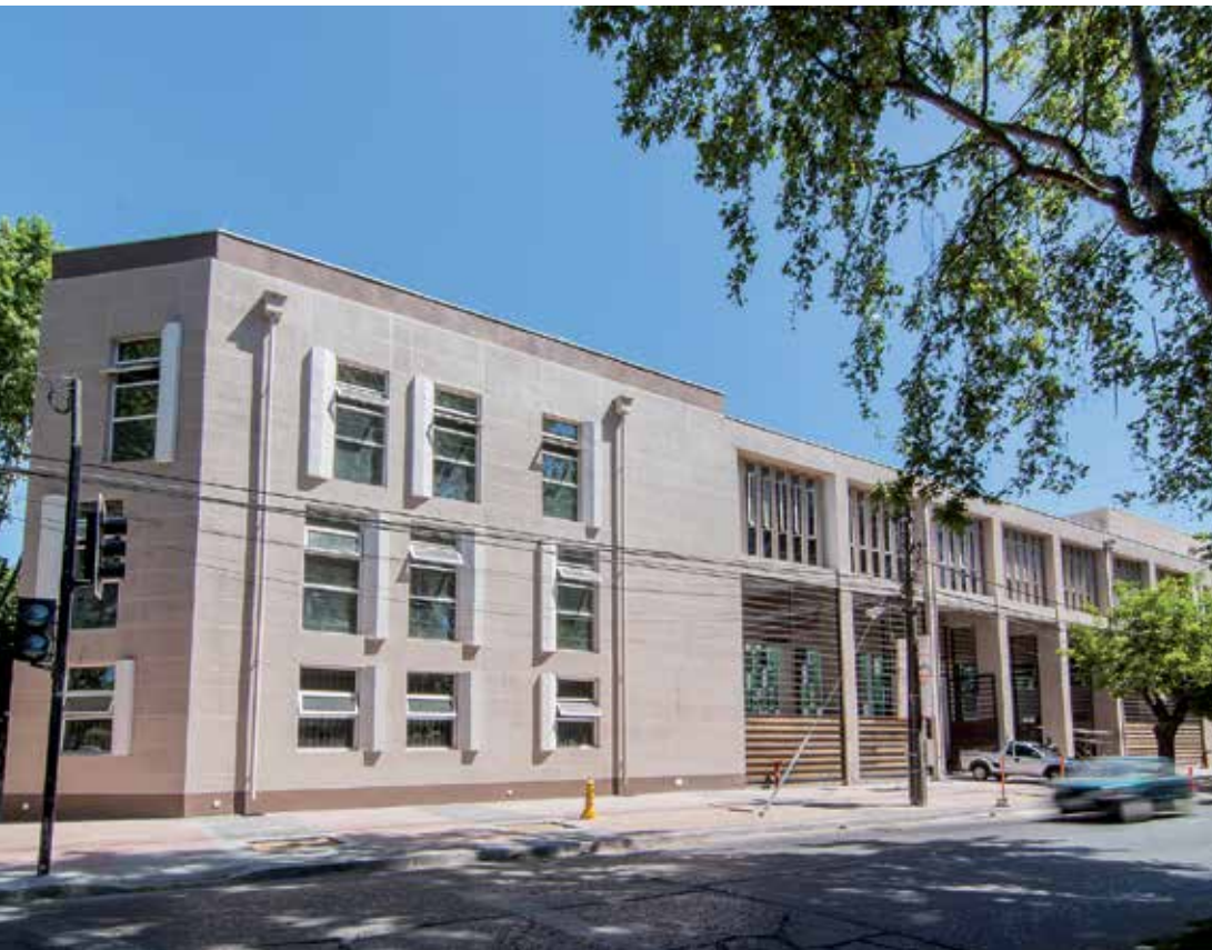
Fachada principal e ingreso
