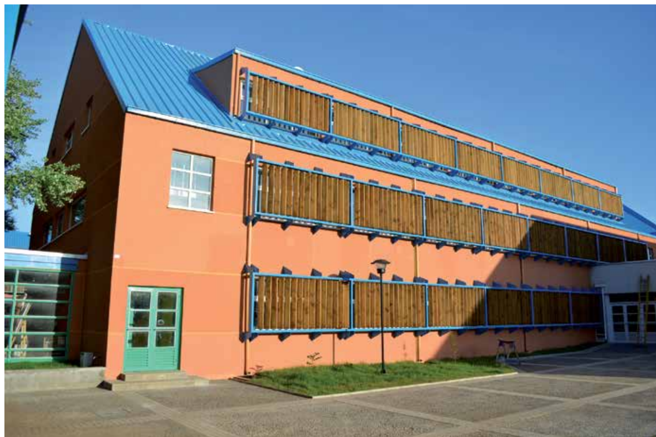
Vista de la fachada que cuenta con un sistema de control solar e iluminación, construido con una estructura metálica y elementos verticales de madera sobre las ventanas de las aulas.
