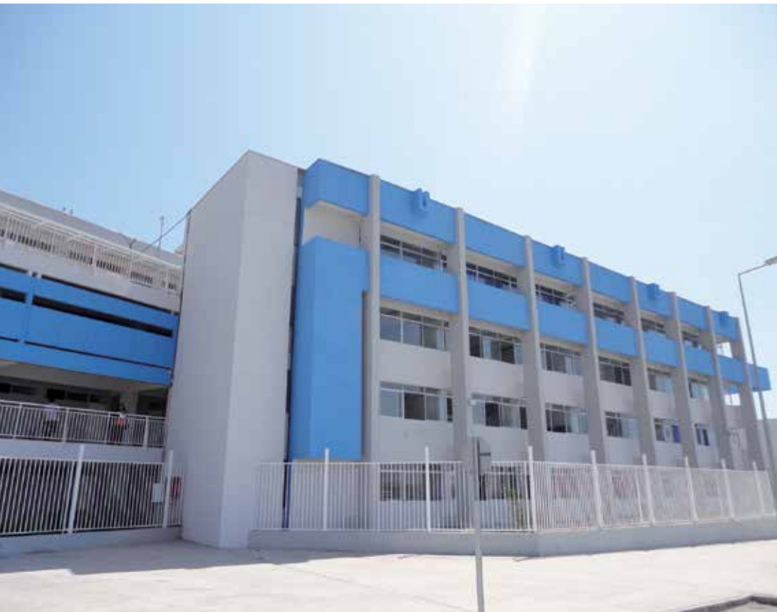
Vista de la fachada principal.
