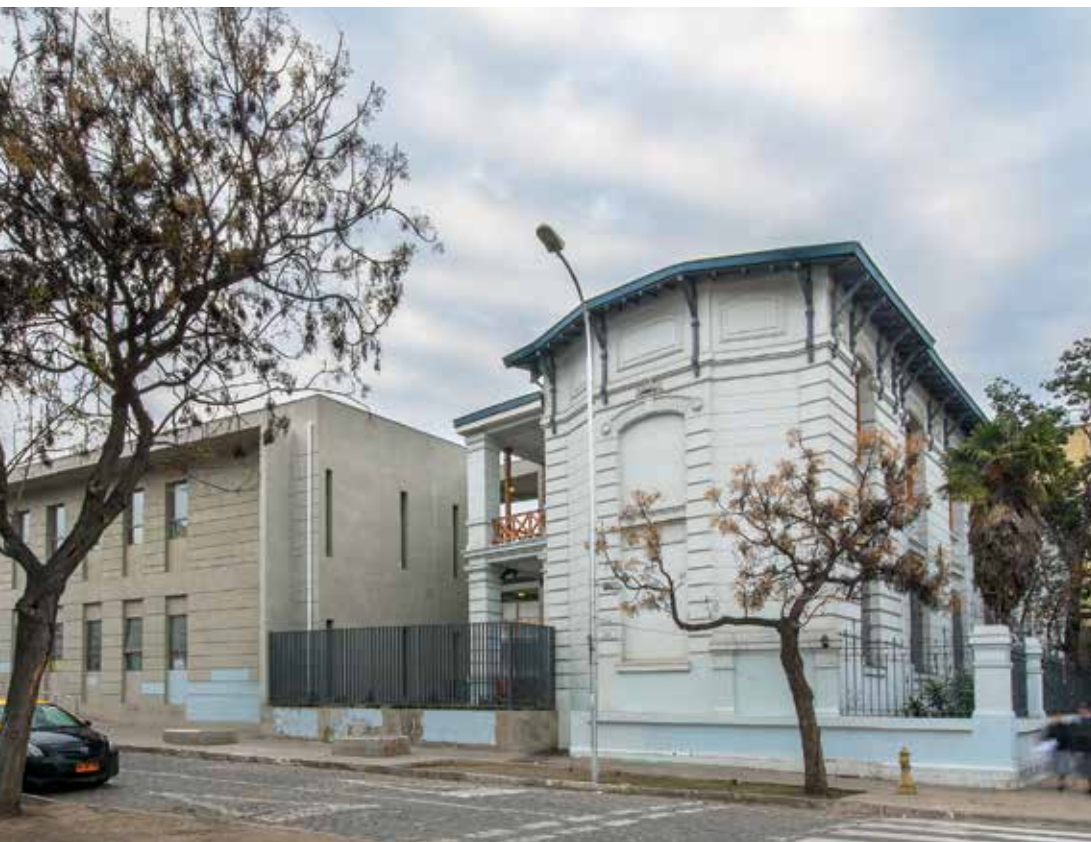
Vista lateral del edificio.
