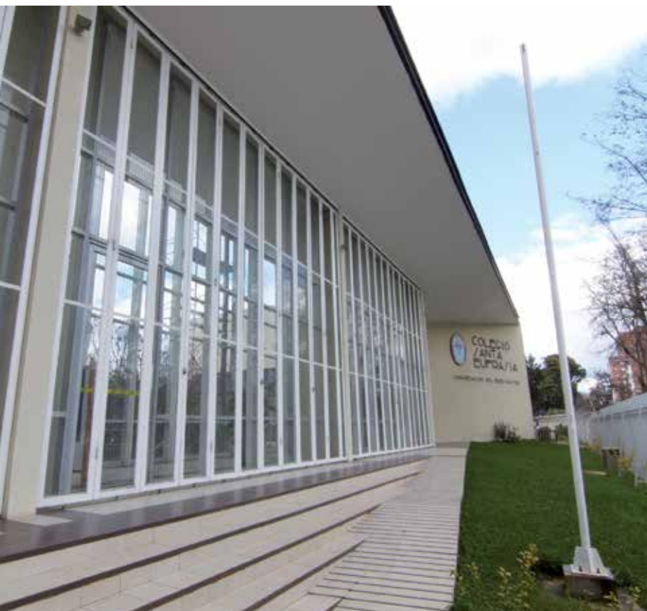
Vista de la fachada principal.
