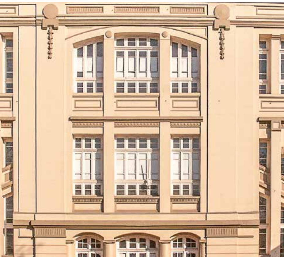
Detalle de fachada
