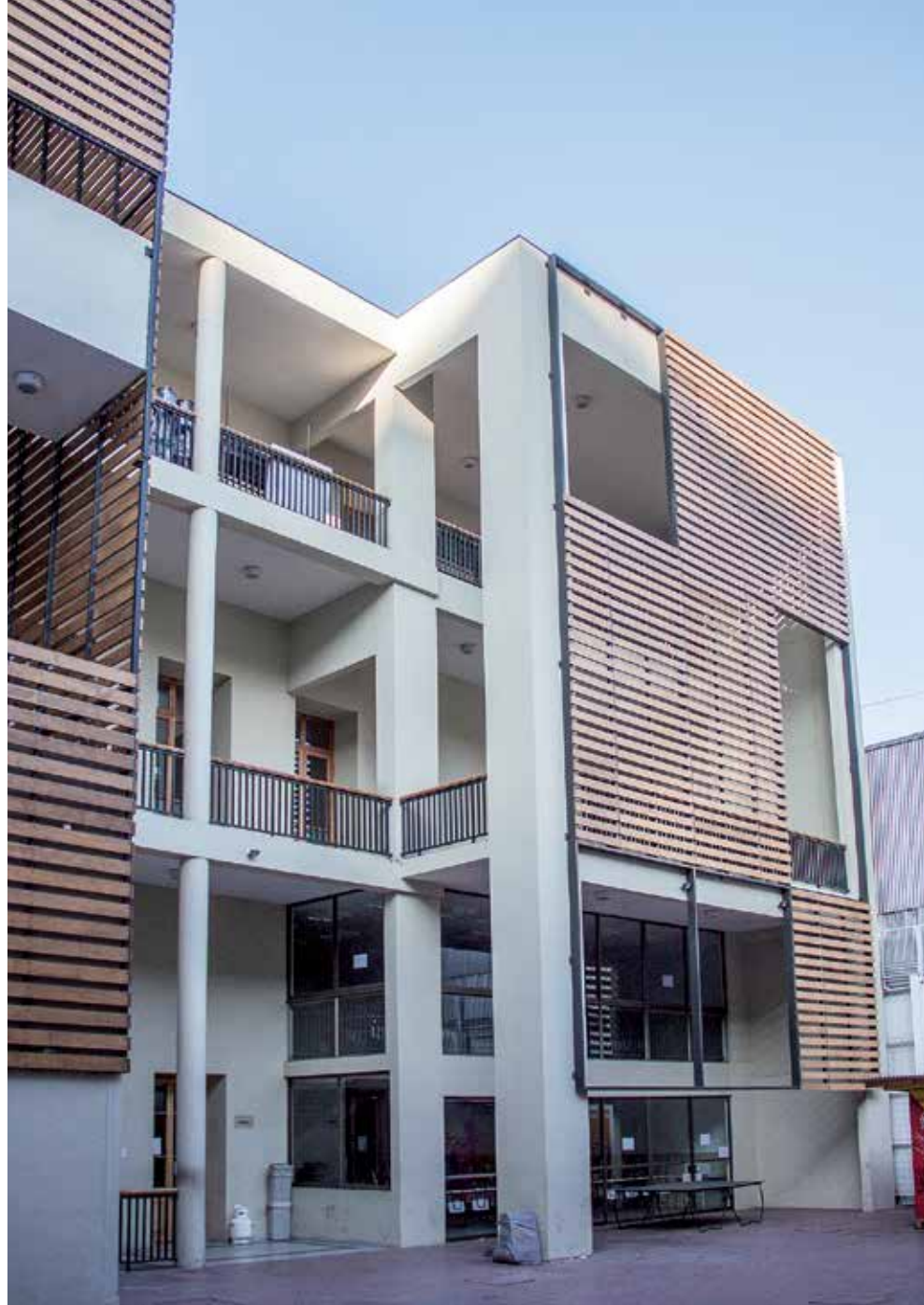
Las nuevas celosías controlan el traspaso de la luz natural en la fachada norte.
