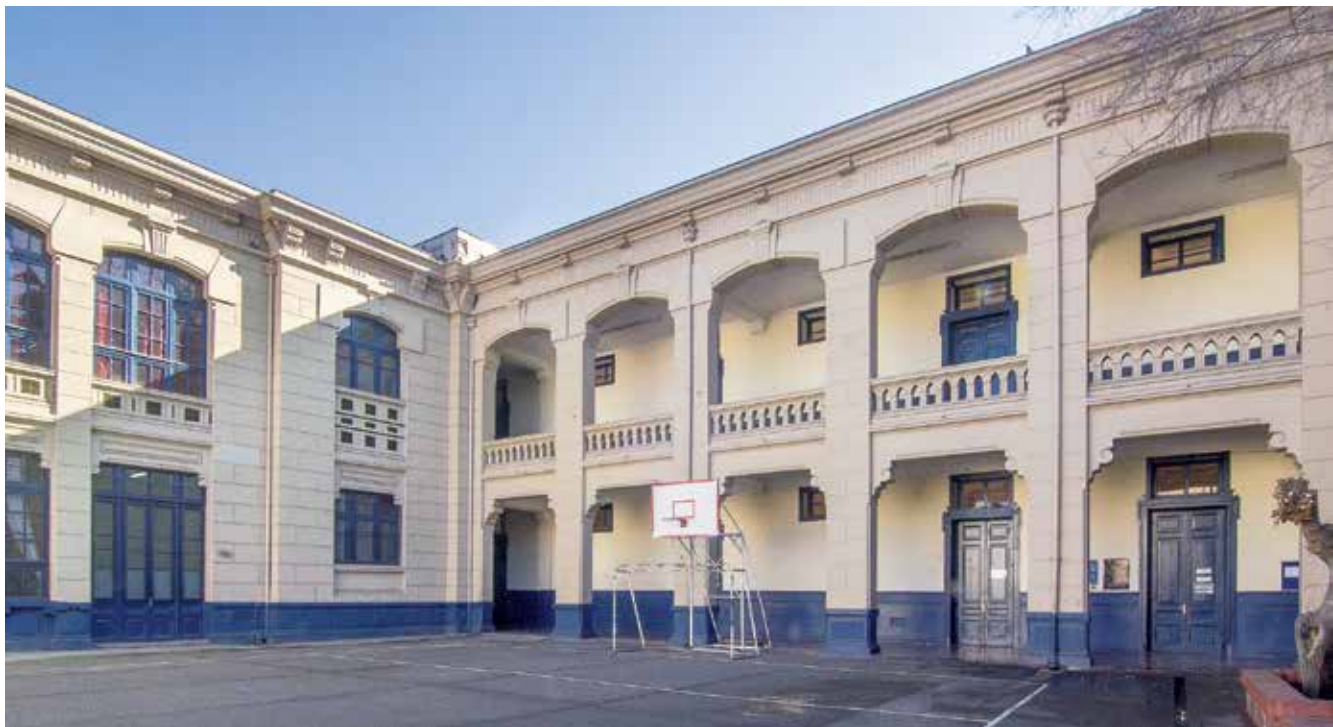
Vista del patio abierto.
