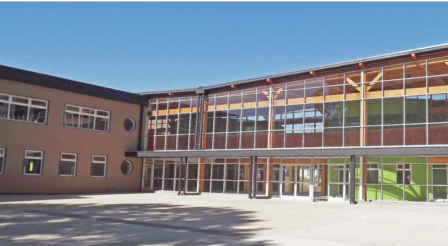
Vista de los pilares y vigas de madera laminada que se dejan ver a través de la fachada transparente.
