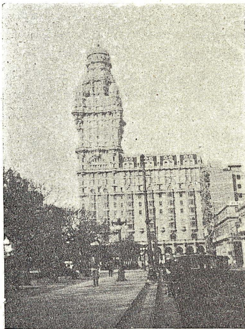
El Palacio Salvo, el edificio mas alto de Sud América, con 26 pisos. Montevideo.
