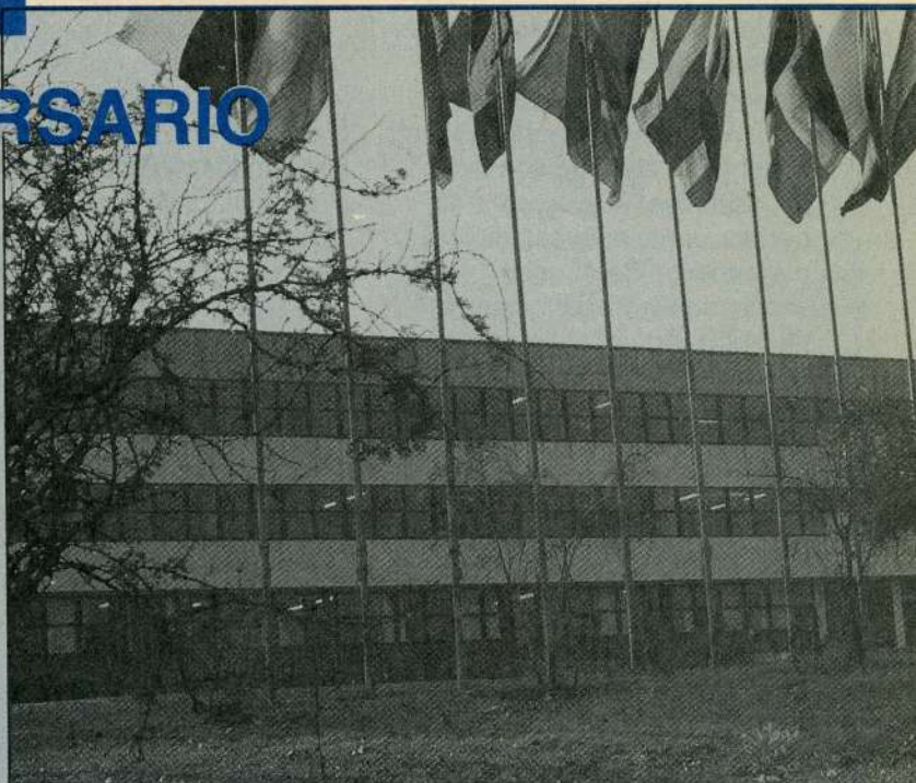
Edificio del Centro de Perfeccionamiento, Experimentación e Investigaciones Pedagógicas.
