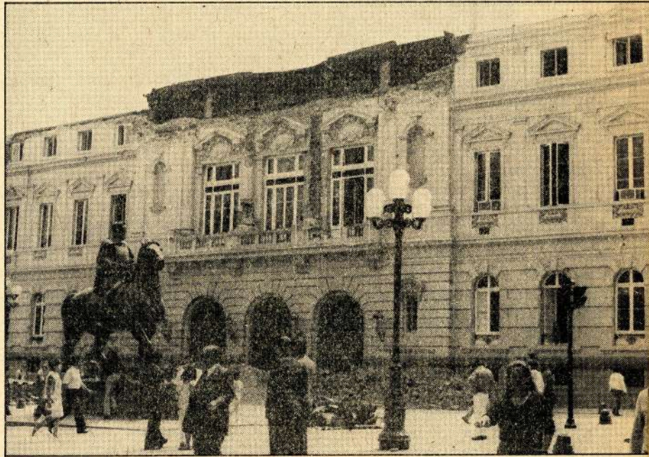
“Los calofríos trágicos y oscuros / van abriendo en las grietas de los muros / las recuperaciones de la nada” (Juan Guzmán Cruchaga).
