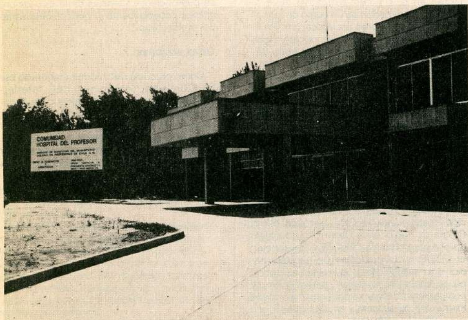
El Hospital del Profesor, ubicado en Santiago, está en proceso de término de sus instalaciones, gracias al aporte de SERBIMA.
