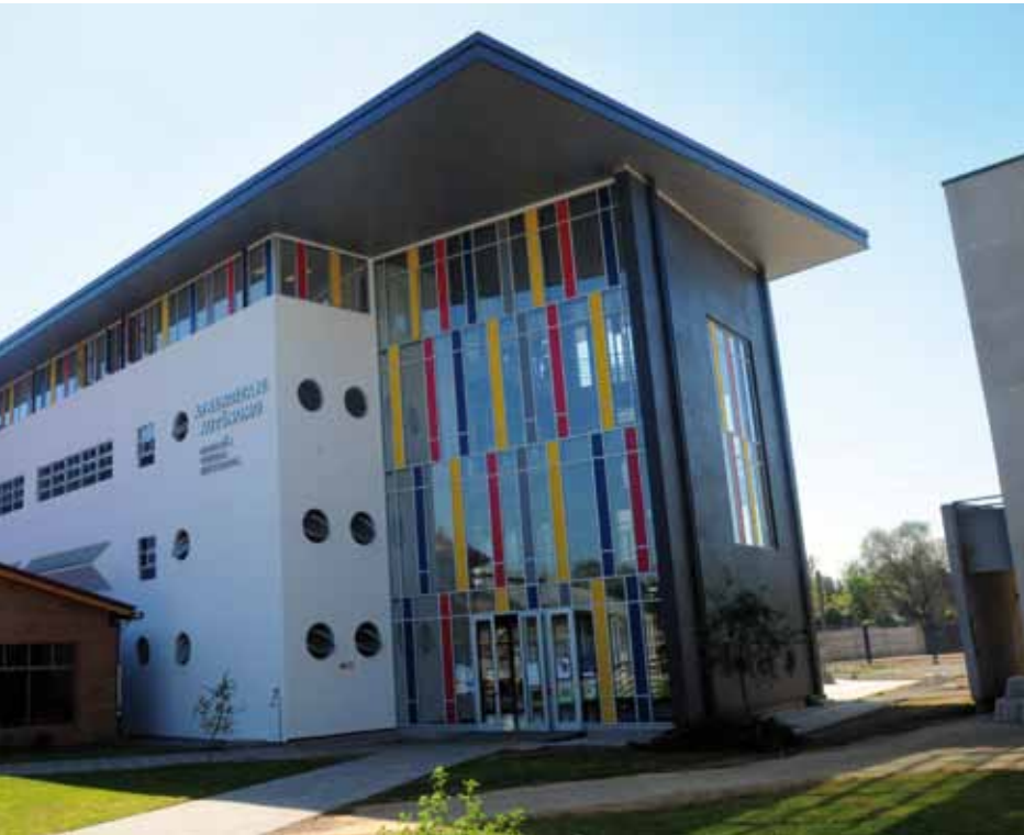
"Edificio Aprendizaje Autónomo Campus San Miguel, Universidad Católica del Maule", proyecto de la Universidad Católica del Maule que fue apoyado por el Fondo de Reconstrucción
