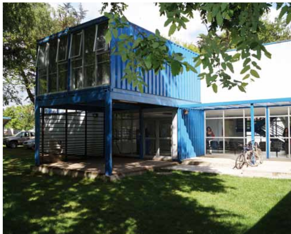
Proyecto "Reposición de laboratorios y construcción de nuevos espacios para fortalecer la docencia de pre y postgrado impartida por el Departamento de Educación Física, Deportes y Recreación", Universidad de La Frontera
