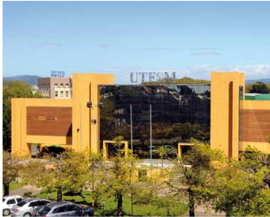
"Recuperación Patrimonial de la Universidad Federico Santa María, derivado de los efectos provocados por el terremoto", proyecto de la Universidad Federico Santa María que fue apoyado por el Fondo de Reconstrucción
