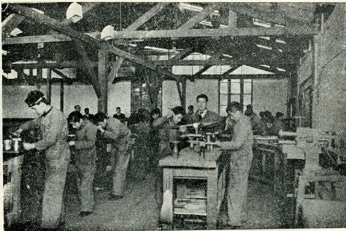
ESCUELA NACIONAL DE INSTALACIONES SANITARIAS.- Santiago.- Uno de los talleres en el que los alumnos se capacitan para llevar a todos los ámbitos del país el confort y la higiene en la vivienda. Con su colaboración se obtendrá que el alcantarillado, el baño, la calefacción, lleguen aun al más humilde de los hogares.
