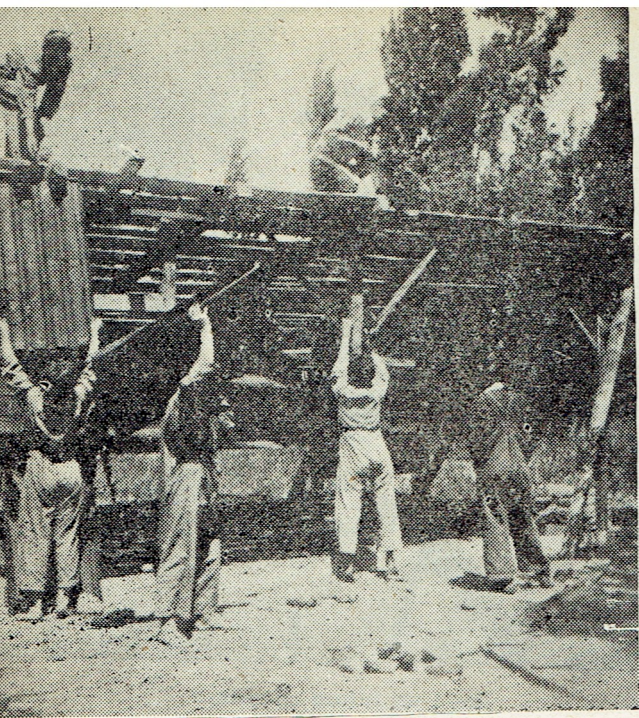
Construyendo un gallinero
