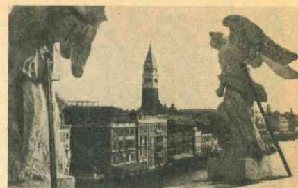
Estatuas reforzadas con estacas metálicas, a fin de evitar su derrumbamiento.
