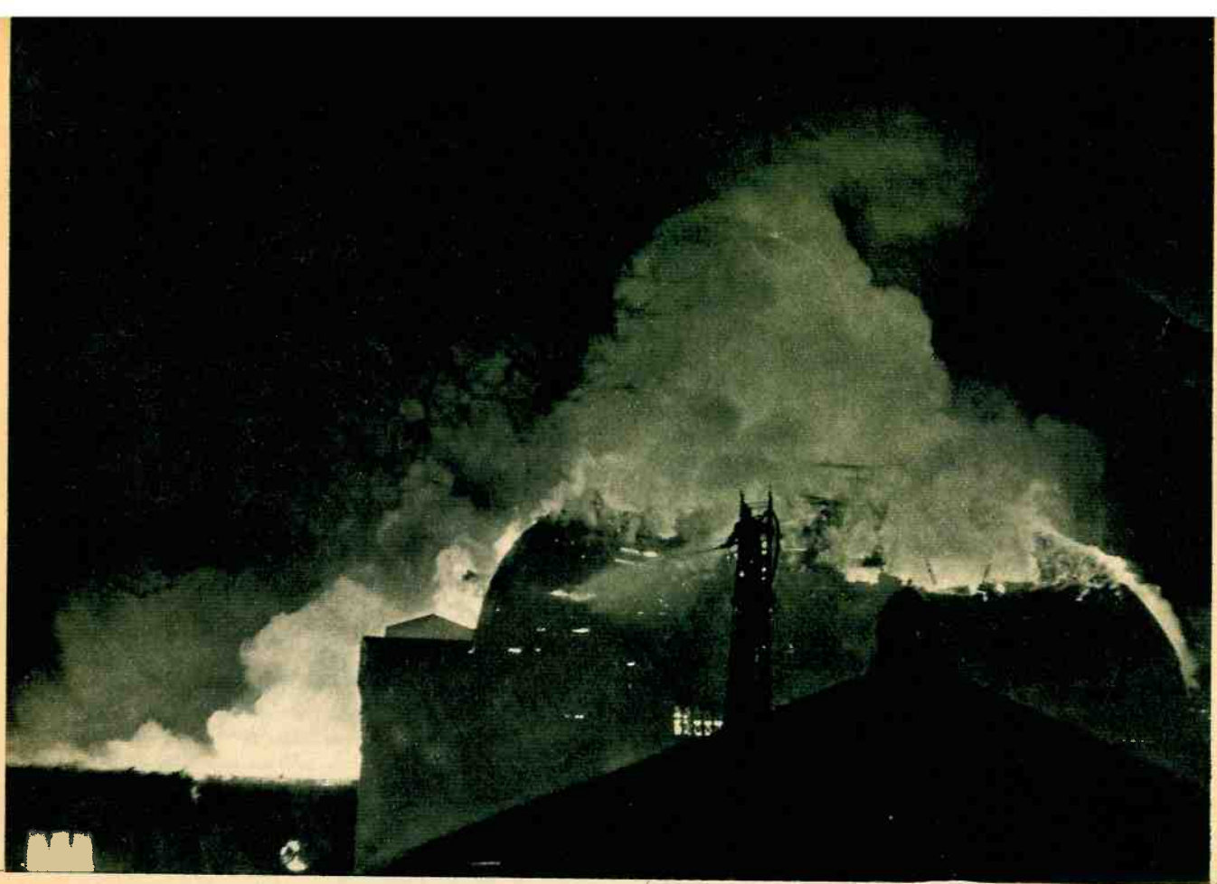
10 de julio de 1969: se incendia la Escuela.
