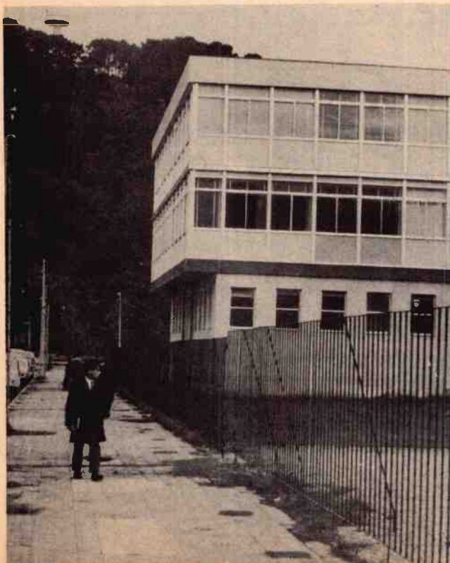
Al nuevo Liceo de Hombres N° 1 de Concepción, como al de antaño en el mismo sitio, le sirve de marco el Cerro Caracol. En la planta baja, las oficinas del prof. Burotto, coordinador de los cursos de perfeccionamiento que imparten los profesores de la Universidad de Concepción
