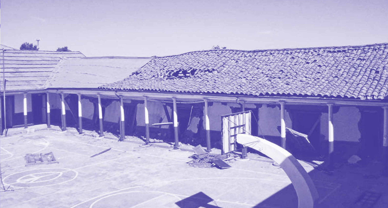
Daños en el edificio del Liceo Nuestra Señora del Tránsito de Molina, Región del Maule. En el libro "La reconstrucción en Educación", Ministerio de Educación.
